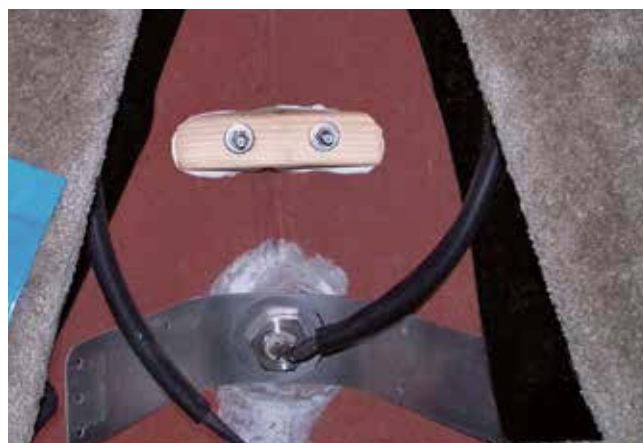
図 30 : 内側から見た取付画像
